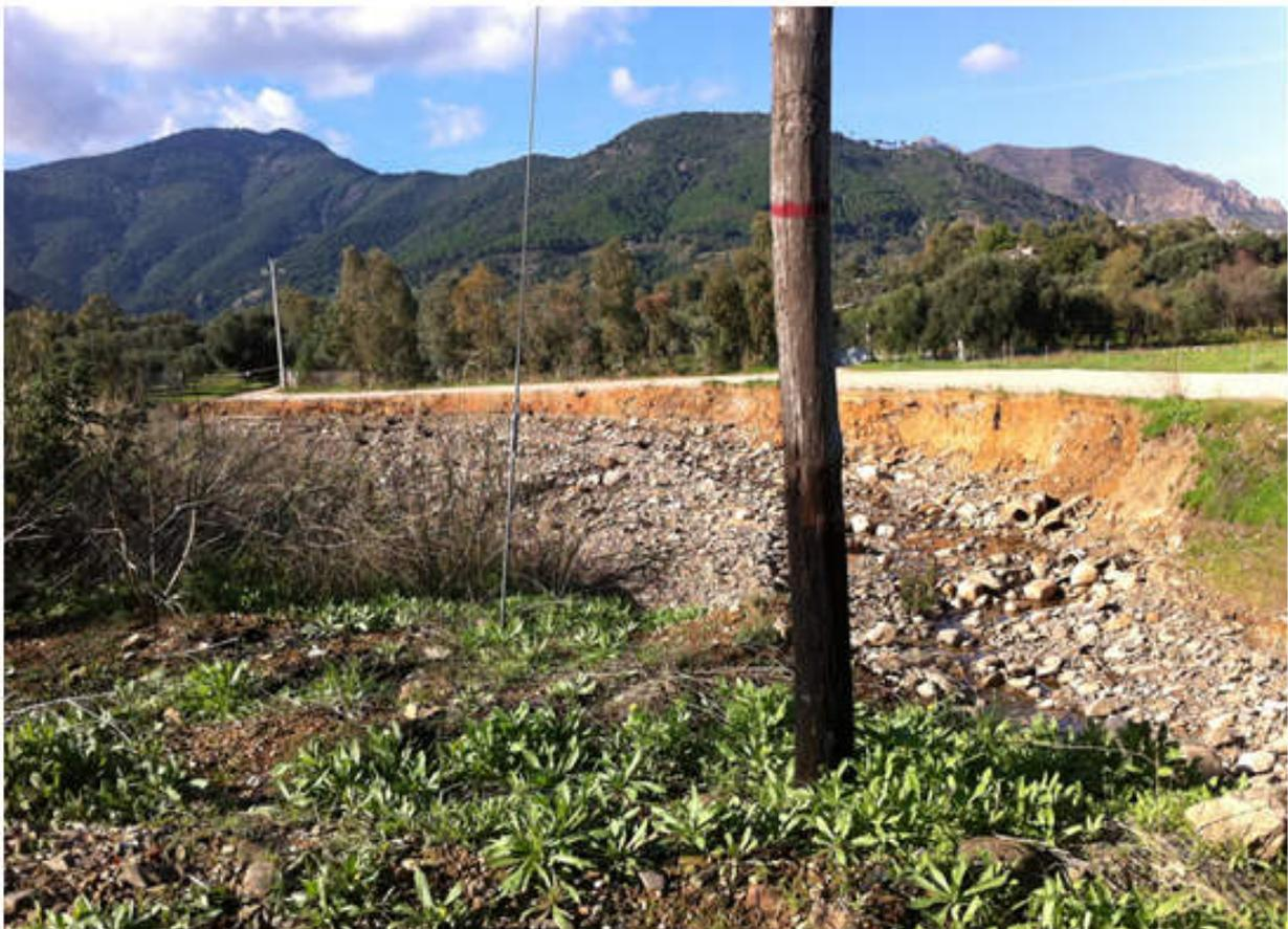
***Erosione della sponda destra del rio Narti in prossimità della via M. Mannu***
