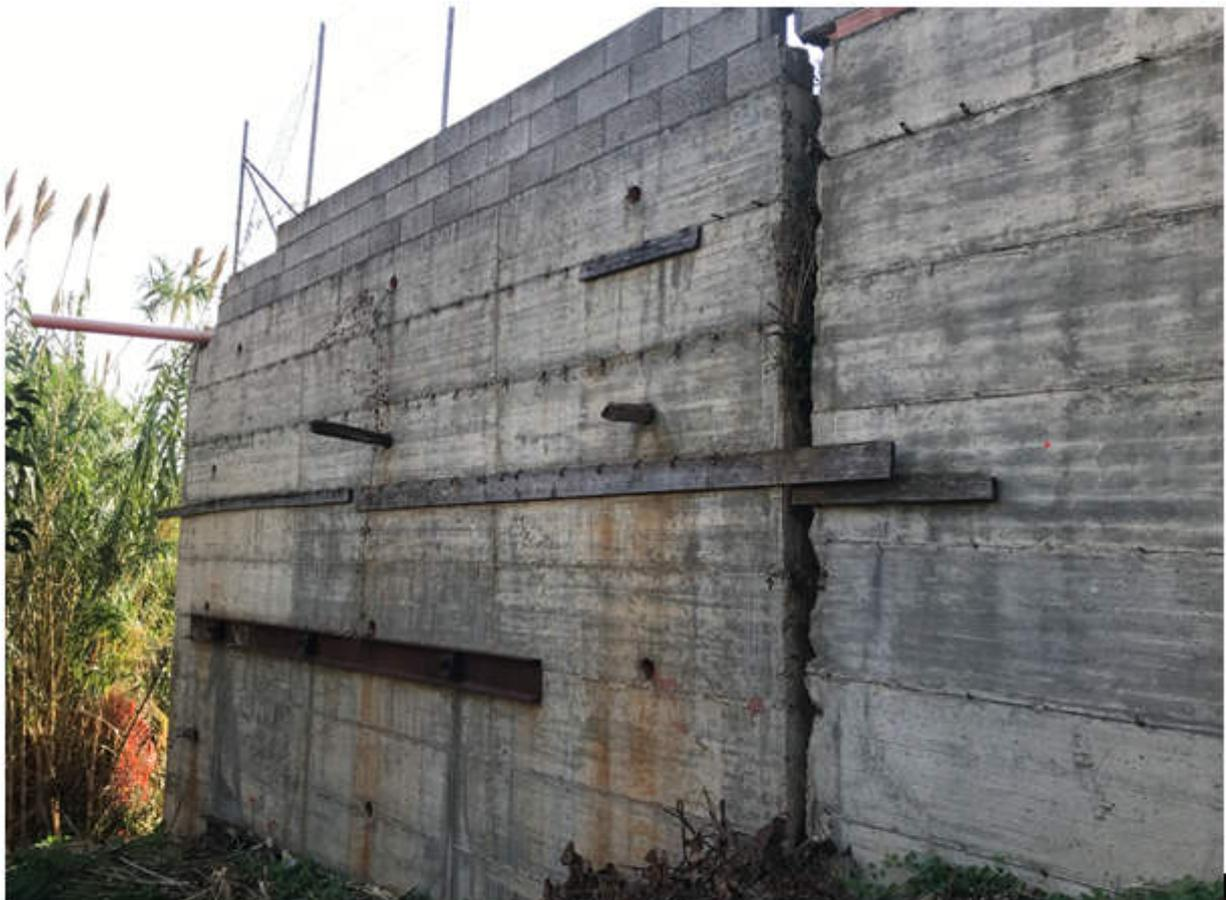
*Cora Brabetza – cedimento di muro di sostegno dovuto all’erosione del corso d’acqua*
