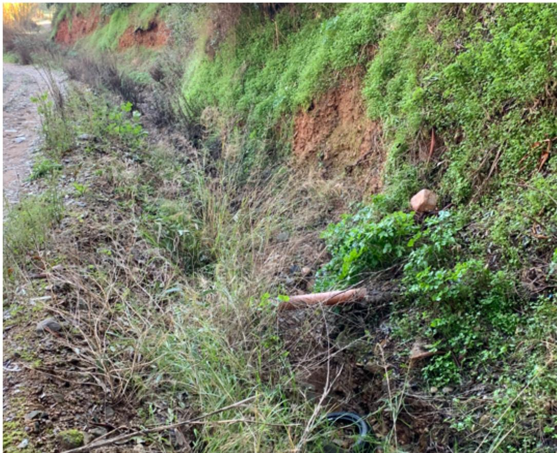
Foto 4 – Erosione fondo con messa in luce del sistema fognario del rio S. Antonio
