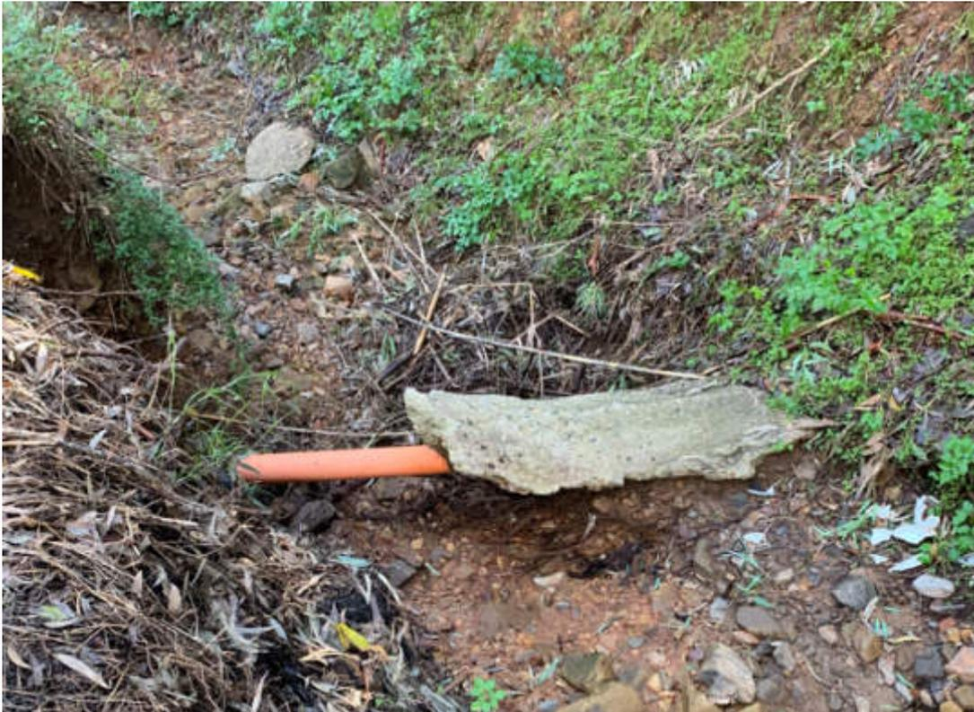
Foto 3 – Erosione fondo con messa in luce del sistema fognario del rio S. Antonio
