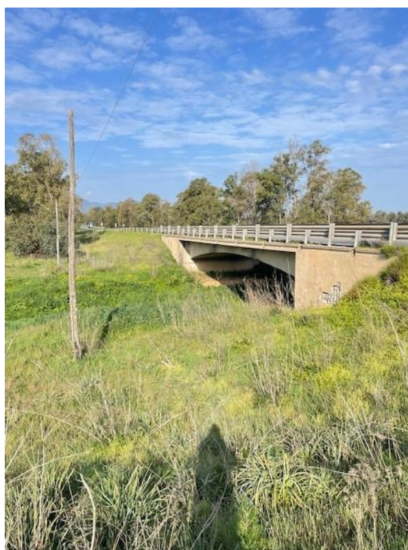
Vista del ponte PO_SS196_19+178 (lato sinistro)
