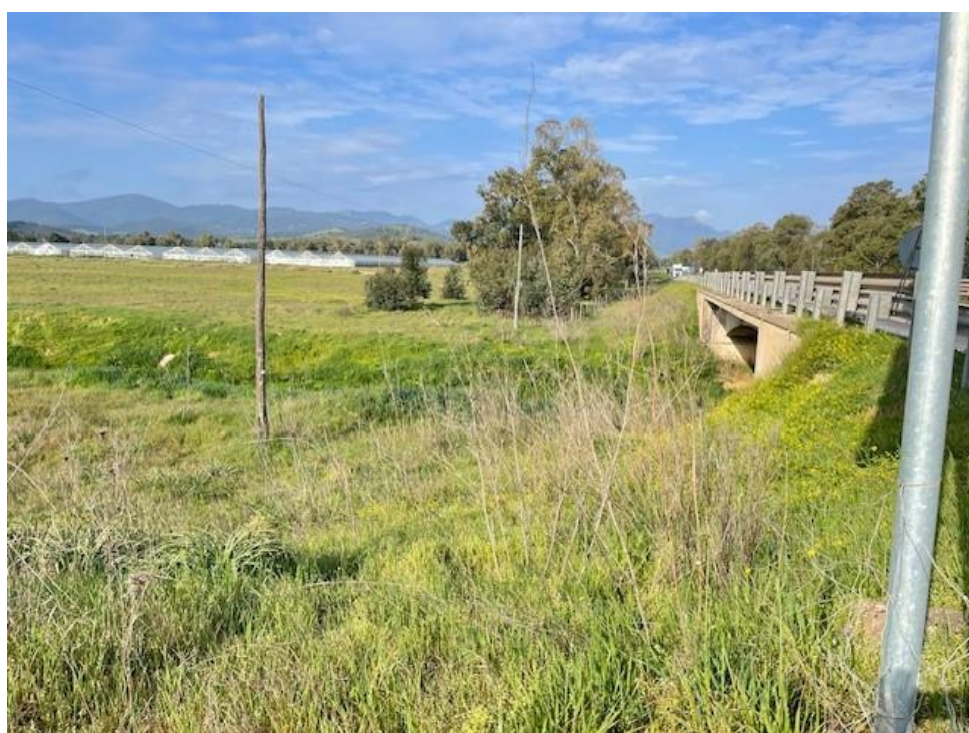
Vista da sud verso nord (lato sinistro)
